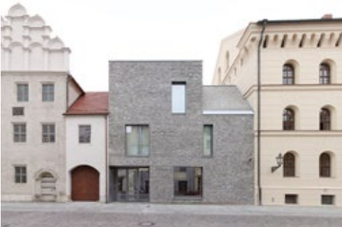
Abb. 35 Umbau und Erweiterungsbau Melanchthonhaus (2013), Wittenberg, dietzsch & weber
