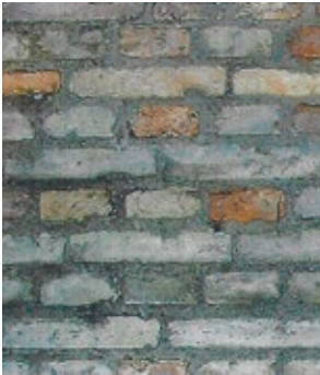
Abb. 18 Flächenhafte Fugenform, Betonung der Ziegelfläche
