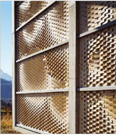
Abb. 60 Fassadendetail Weingut Gantenbein
